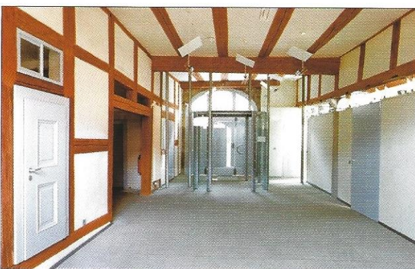
Abb. 6 Arnstadt, Musikschule, im Eingangsbereich im Erdgeschoss wird durch eine Stahl-/Glastrennwand der Windfang abgegrenzt, 1995
