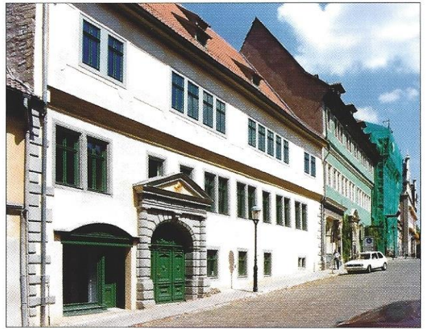
Abb. 1 Arnstadt, Musikschule, die Fassade am Markt übernimmt nach ihrer Wiederherstellung die Putzgliederung der Barockzeit im 2. Obergeschoss, 1995
